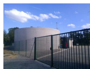
Station d'épuration de Lignièrès
