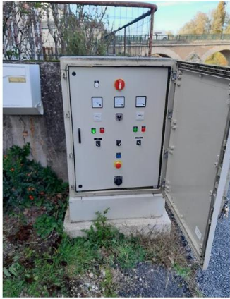
Mise en place d'un arrêt d'urgence pour chaque poste de relèvement sur le réseau d'eaux usées
